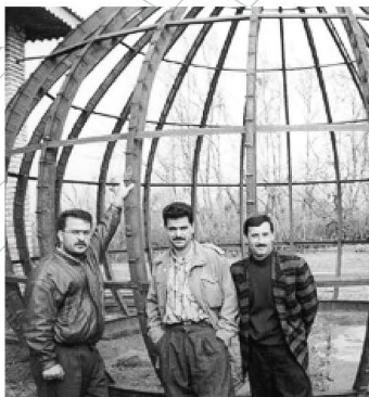
ساخت گنبد فلزی مسجد لنگرود، سال ۱۳۷۵
